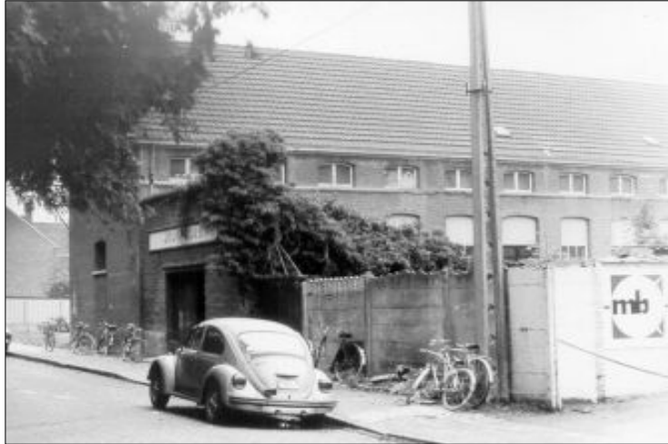
Het restant van de kostschool Otten, in de jaren '70 het jeugdhuis.
